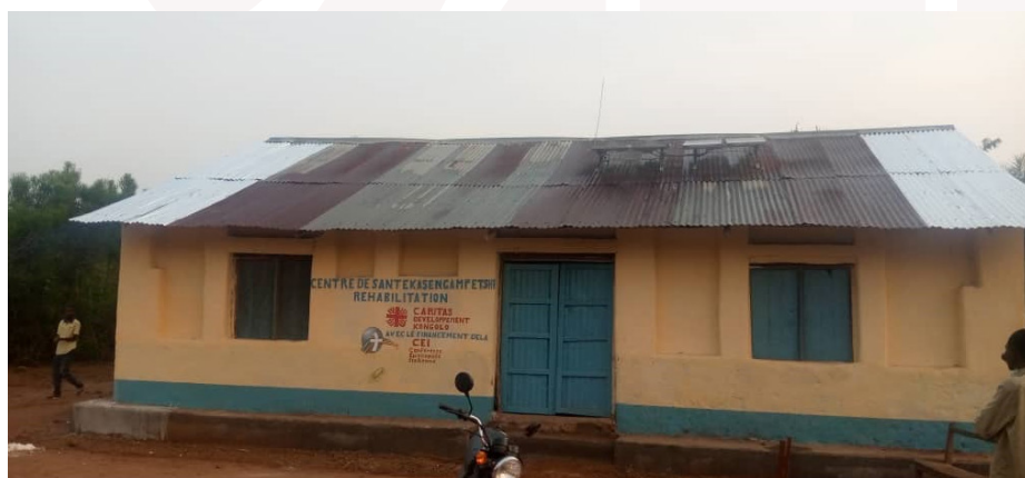
Réhabilitation du Centre de Santé Ekasenga Mpetshi
