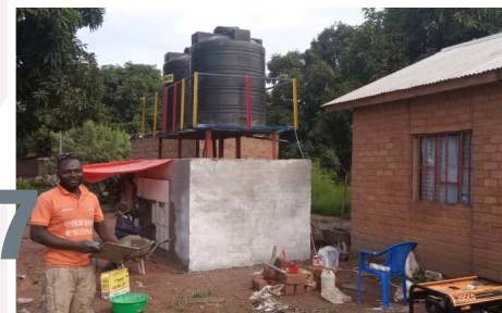
L'une des bornes fontaines installées par le BDD Lubumbashi au village Makondo
