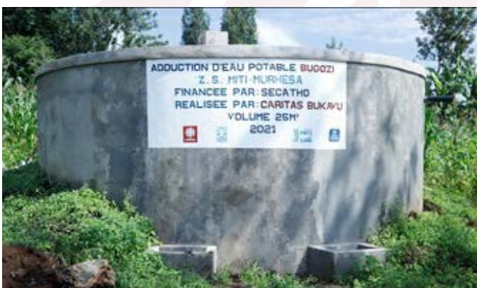
Réservoir de 25 m 3 /MITI-MURHESA
