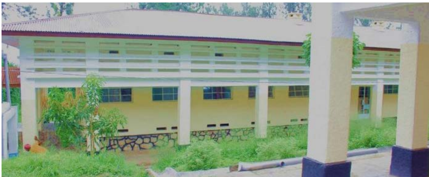
Vue partielle d'un des blocs de l'HGR de Kirotshe réhabilité par le PINS
