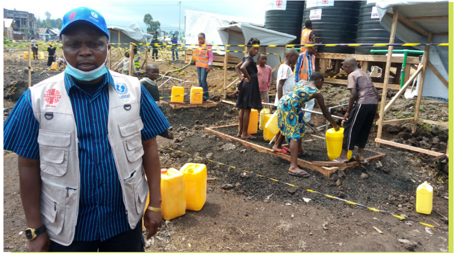
Mr Ladislas Kambale, Chargé de la qualité de Programmes à la Caritas Goma, devant une rampe des robinets servant la population en eau potable sur le site de Don Bosco
