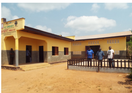
L'un de deux entrepôts communautaires construit par le projet « Un Monde Sans Faim »
